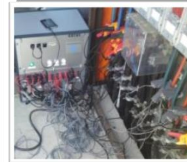
Messung an 8 Transformator-Abgängen im Sekundentakt
